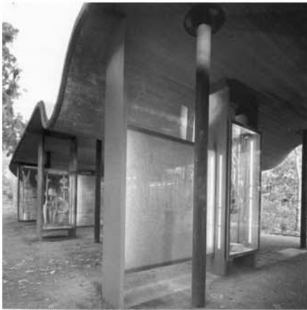
5. First Nations Pavilion Saucier et Perrotte Architectes
